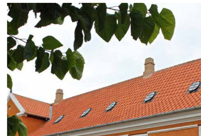
9-stens ovale, koblede tagvinduer, Dantegl, vingetagsten fra Monier på Prinsens Gård, Frederiksberg Have.
