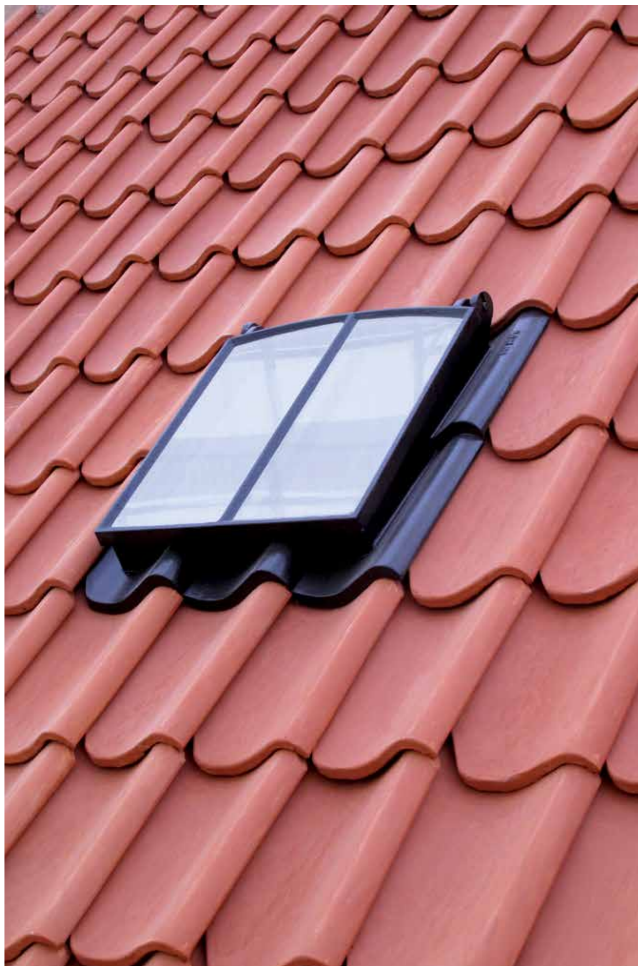
6-stens tagvinduer i støbejern med én lodret sprosse, Dantegl, JP2 håndstrøgne vingetagsten fra Monier. Nylagt i 2020 under igangværende renovering af Nyboder, København.
